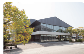
C 2号館（地域交流棟）
