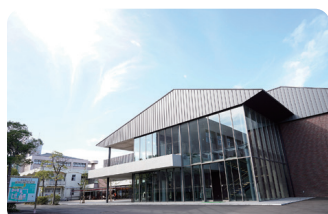
F 1号館（本部棟）
